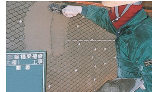
チタンメッシュ施工状況
