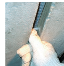
平置き施工状況
