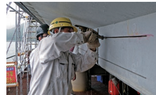
チタンリボンメッシュRMV陽極施工状況
