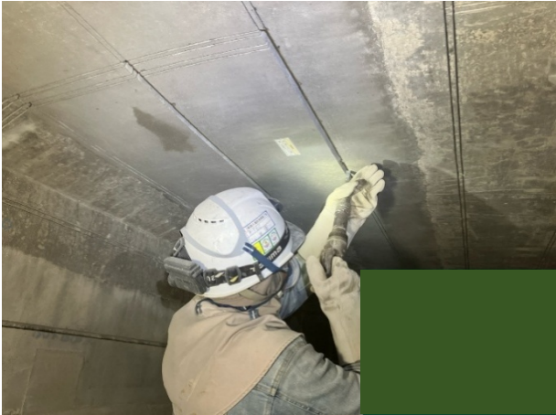
溝はつり状況
