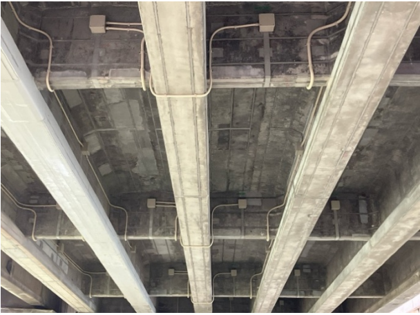
陽極設置・配線配管完了
