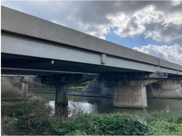
橋りょう全景
