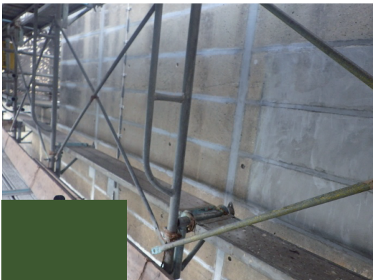
リボンメッシュ陽極設置完了
