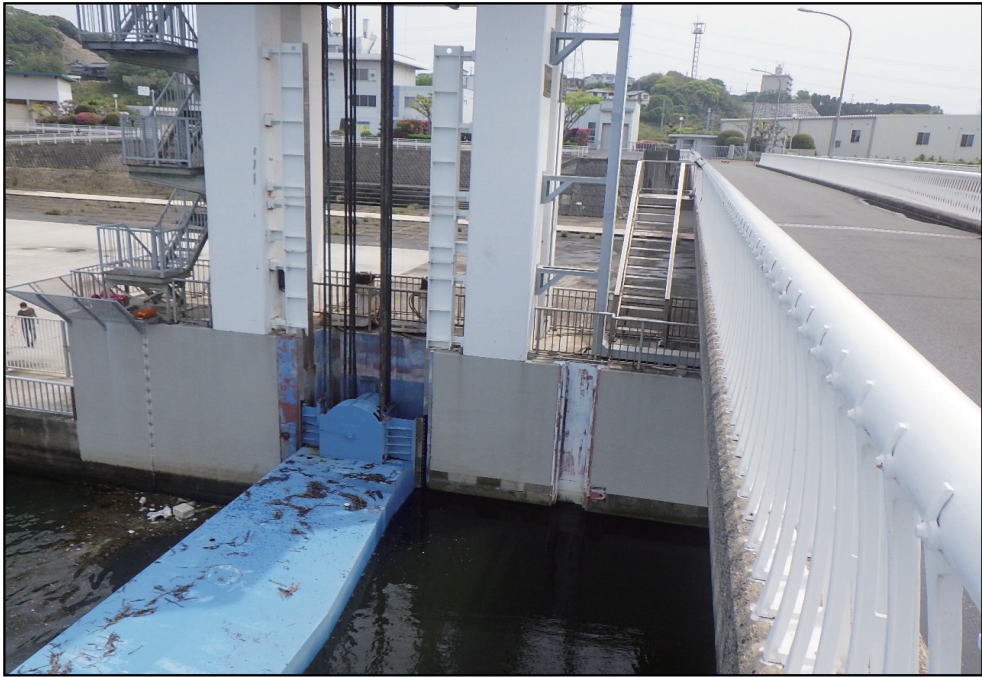
施工完了（電気防食＋塗装）
