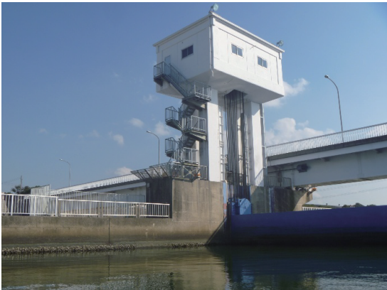
施工前 河口堰（P 9）
