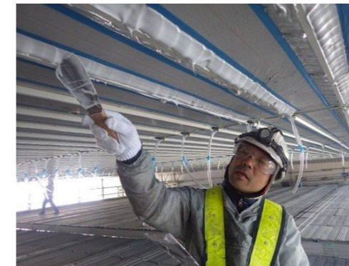
線状陽極収納樹脂製モール設置状況 エポキシ樹脂シール
