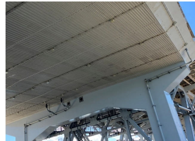
線状陽極収納樹脂製モール設置状況 エポキシ樹脂シール
